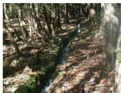
空積水路(近景)
