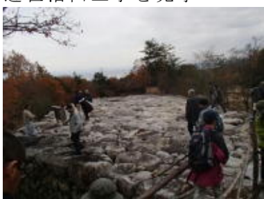
堰堤天端(空石積み)
